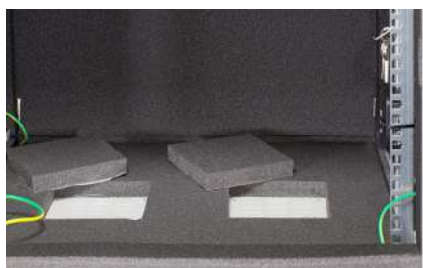
Prédécoupe pour passage de câbles
