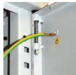
Emplacements pour câbles de mise à la terre intégrés aux montants arrières.
